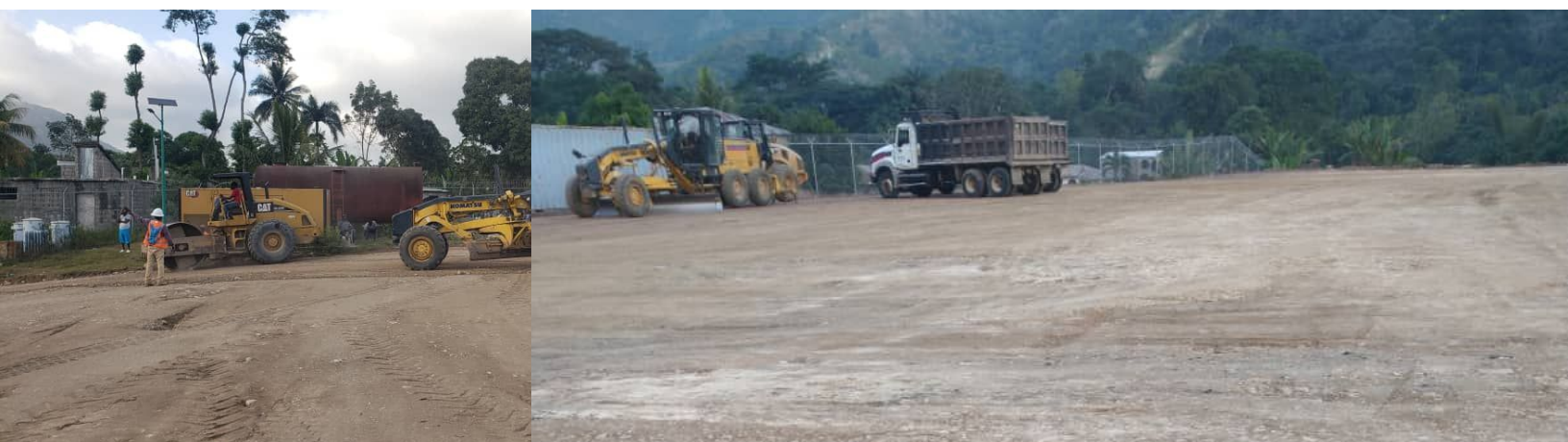
Construction de la centrale de Dondon - United Arab Emirates + Caribbean Renewable Energy Funds - En attente de décaissement.
